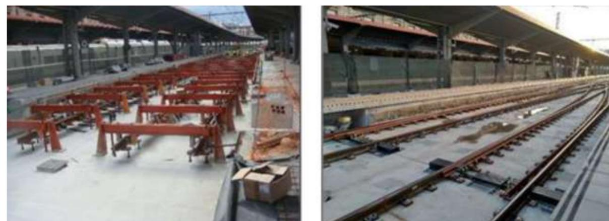
Figura 15. Sistema Top Down o embebido.
