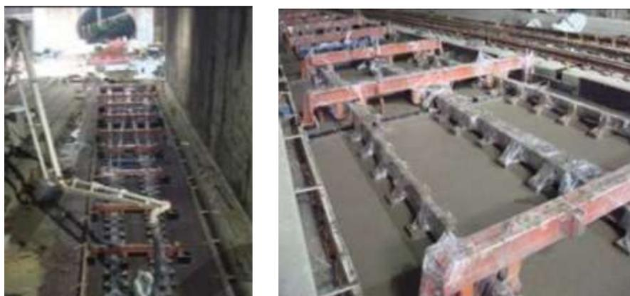
Figura 25. Fase de hormigonado. Vertido y compactación. Acabado superficial
