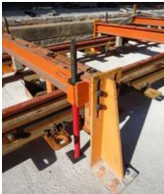
Figura 17. Anclaje de vigas portantes
