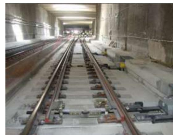
Figura 22. Desvío montado sobre traviesa de hormigón con esperas de acero
