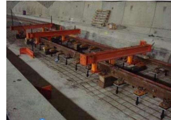
Figura 16. Viga portante con sistema PAD
