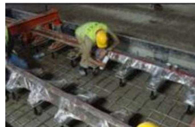
Figura 24. Protección de componentes
