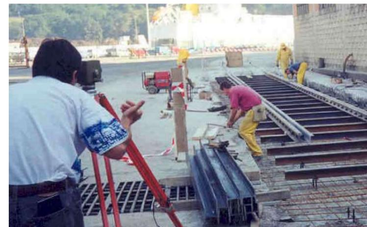
Figura 11. Ajuste topográfico
