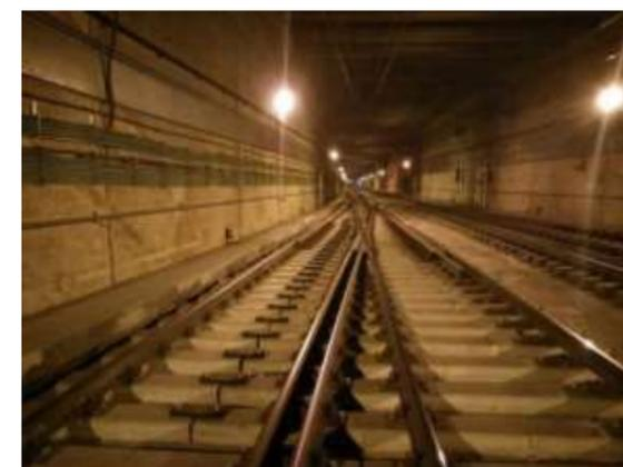
Figura 21. Desvío montado sobre traviesas de hormigón con cazoleta
