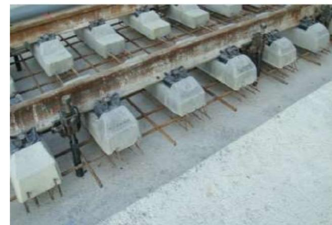
Figura 4. Emparrillado y colocación de husillos de nivelación
