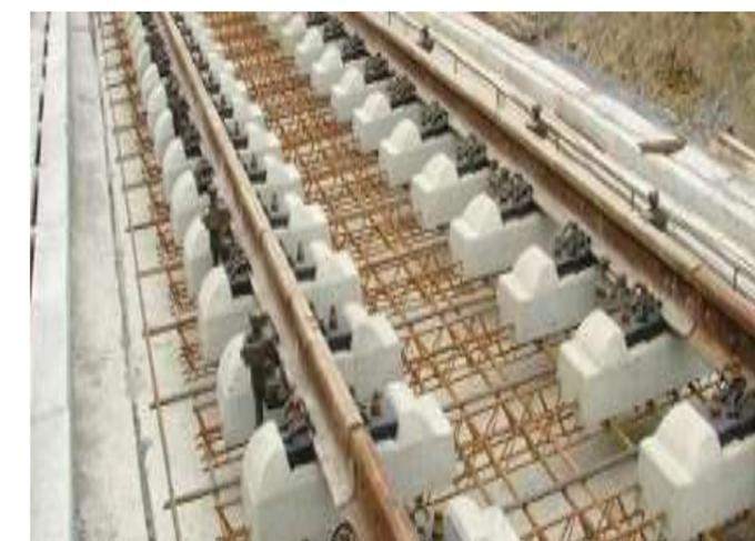
Figura 1. Posicionado de armadura, traviesas y carril
