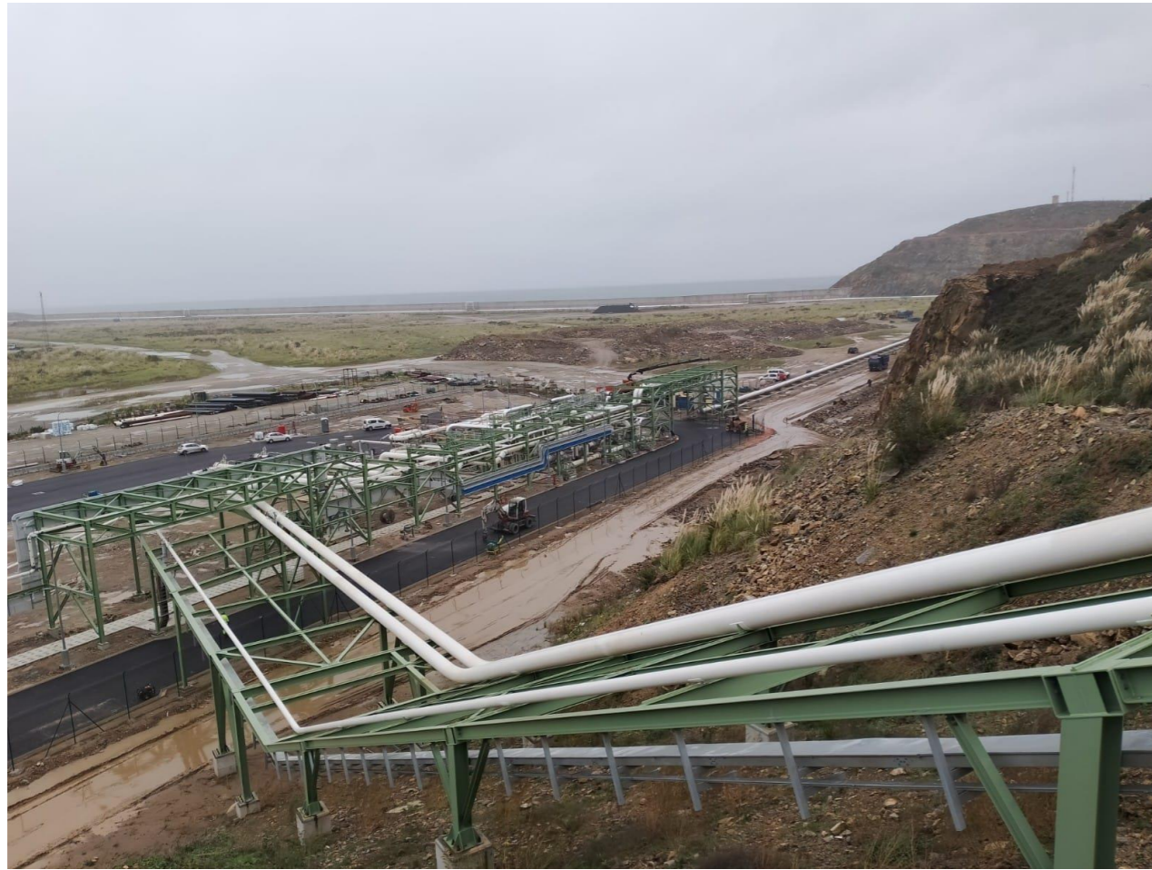
Figura 2. Vista de poliducto a las Instalaciones Portuarias de Repsol
