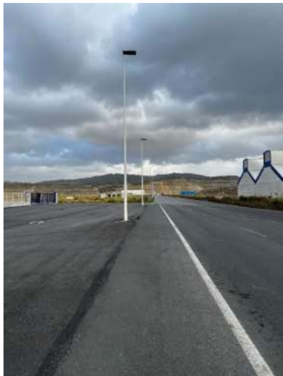
Foto 25. Línea de luminarias
