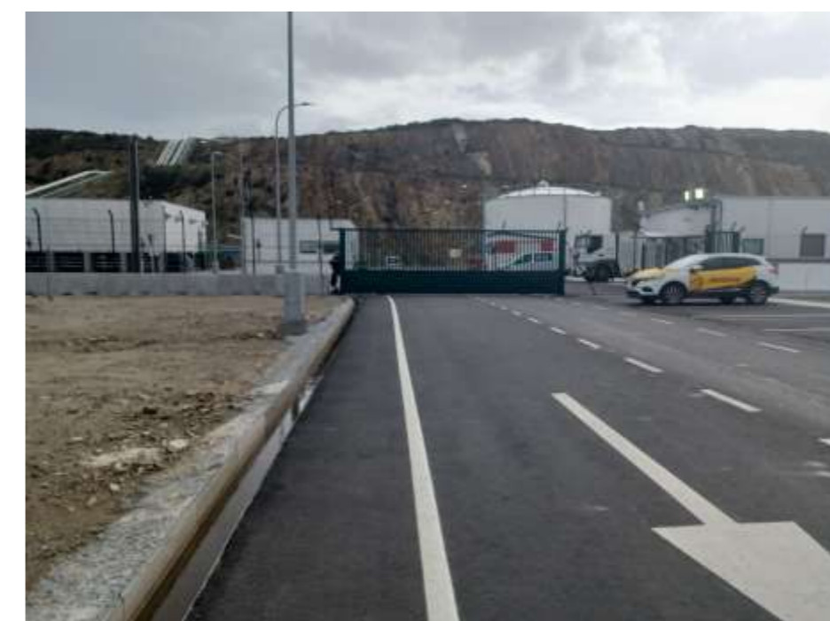
Foto 2. Acceso a instalaciones de Repsol
