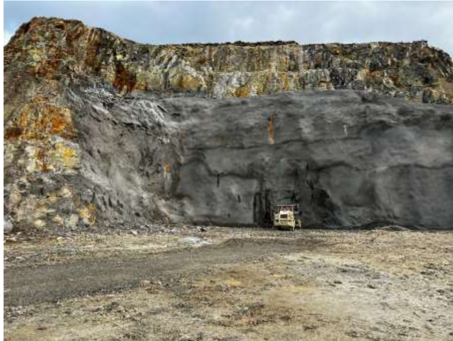
Foto 32. Emboquille del túnel de acceso al Puerto
