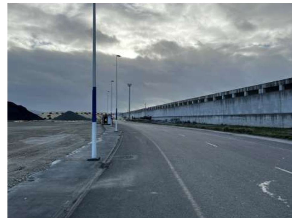
Foto 10. Vial principal en el dique
