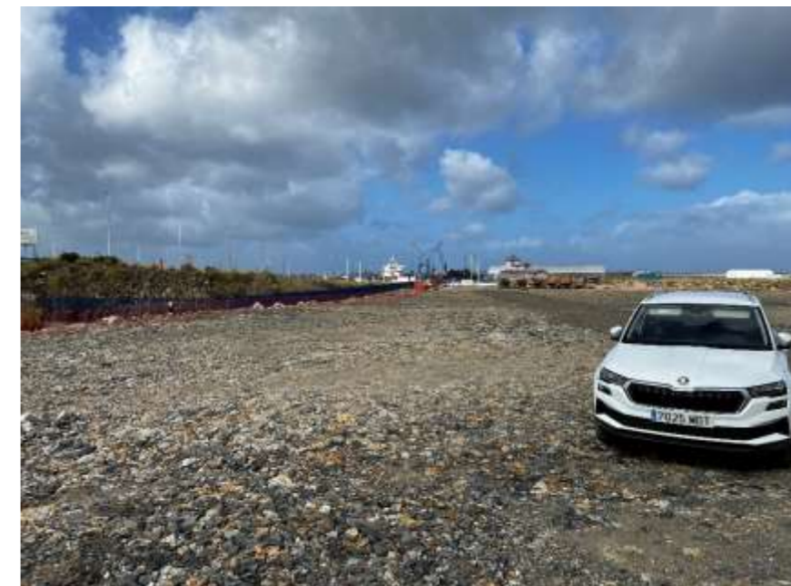
Foto 35. Emboquille del túnel de acceso al Puerto
