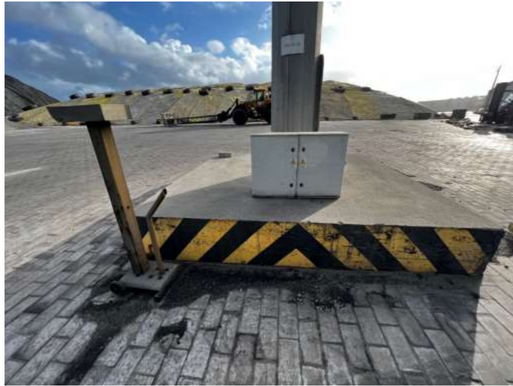
Foto 29. Torre de iluminación
