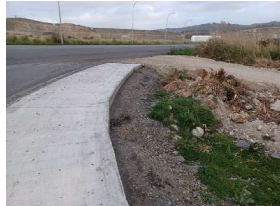
Foto 5. Cruce entre vial principal y acceso a muelle
