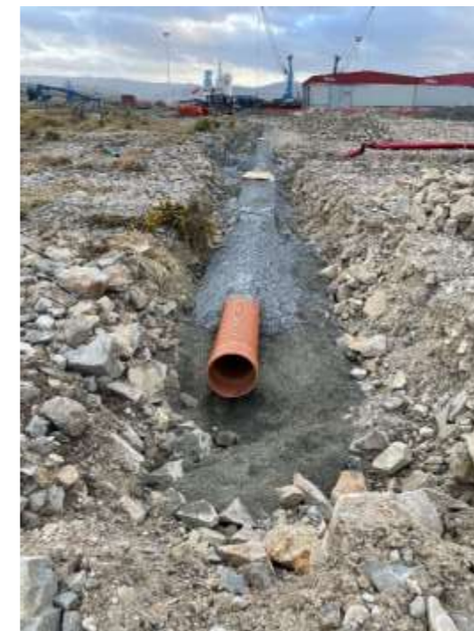
Foto 23. Conducción en ejecución
