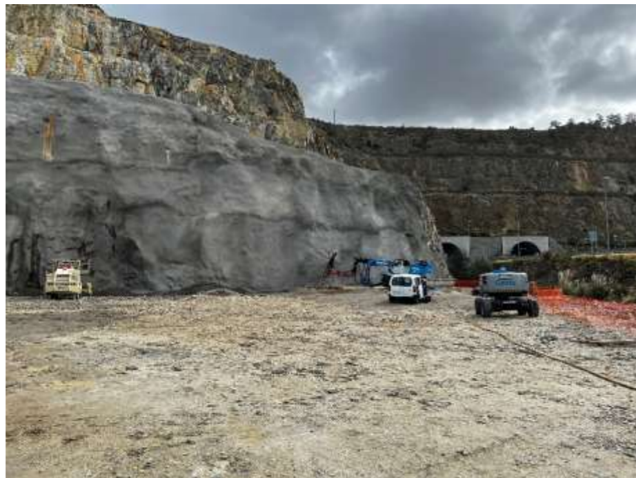
Foto 33. Emboquille del túnel de acceso al Puerto
