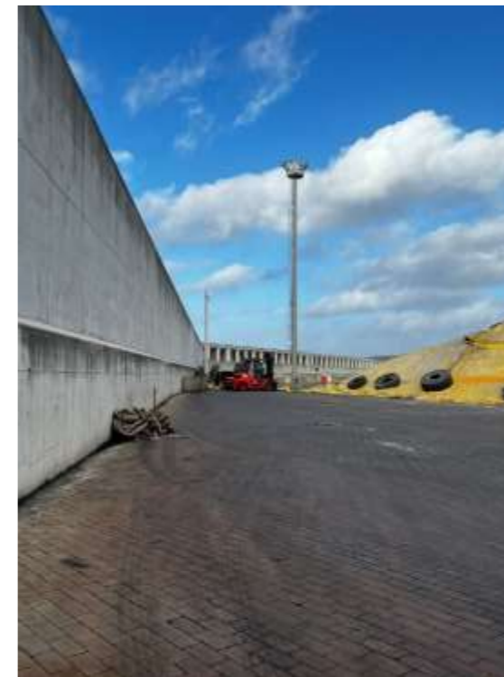
Foto 31. Muro del canal del dique
