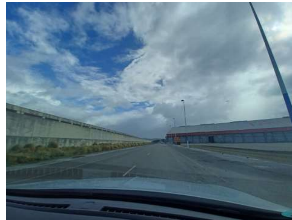
Foto 9. Vial principal en el dique
