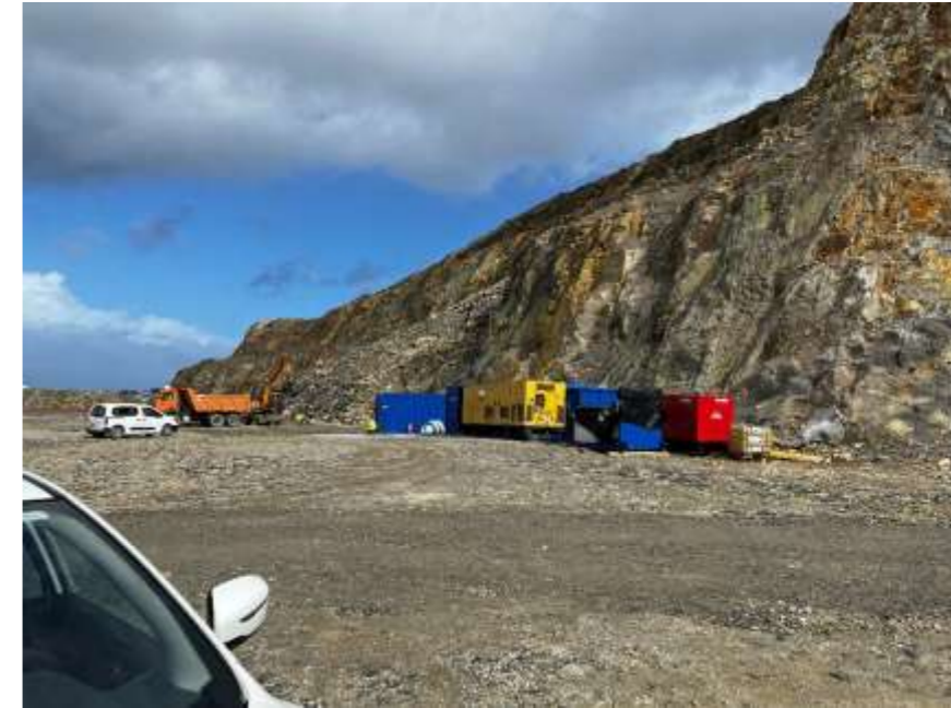
Foto 34. Emboquille del túnel de acceso al Puerto
