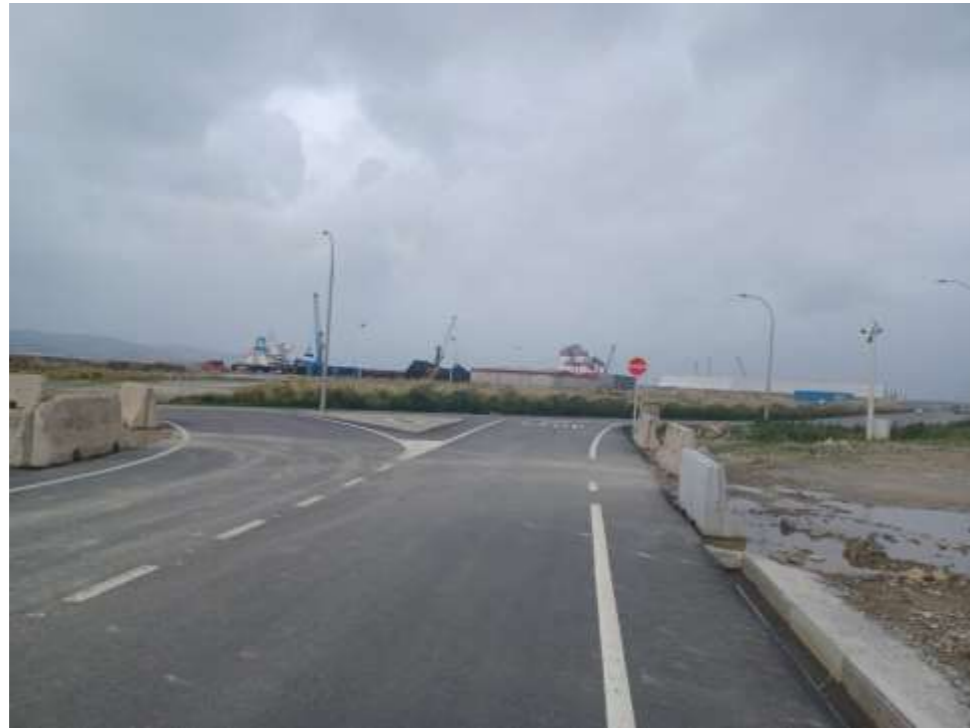
Foto 3. Acceso a instalaciones de Repsol
