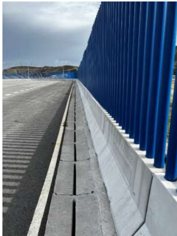
Foto 11. Drenaje de la zona del parking
