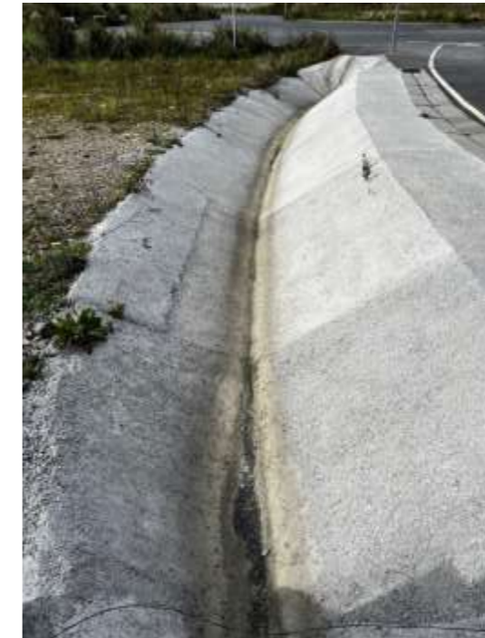
Foto 12. Drenaje de la zona del parking
