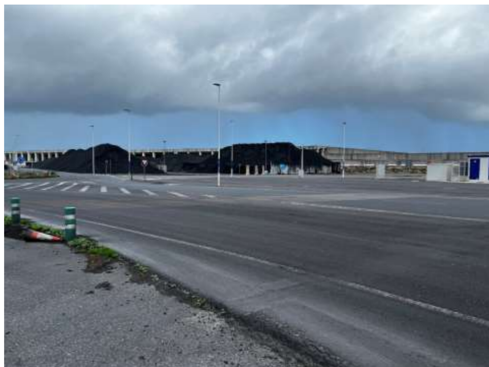
Foto 8. Vista del vial principal en su entronque con la glorieta
