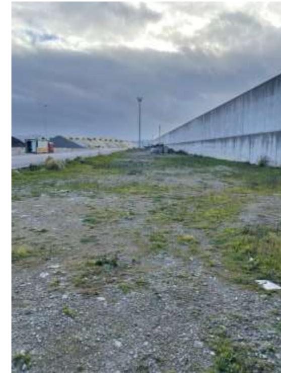
Foto 30. Muro del canal del dique
