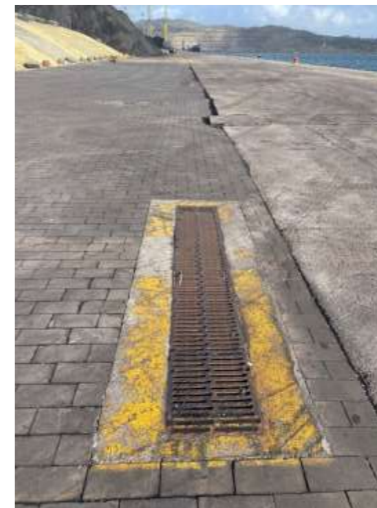
Foto 20. Drenaje existente en muelle
