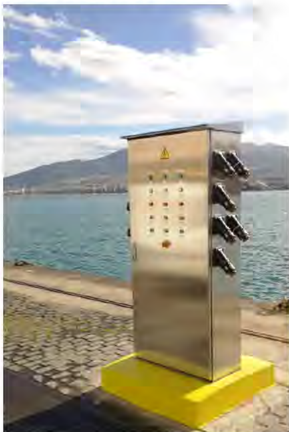
Figura 5.6 Monaguillo de conexión a buques en el Muelle Espigón, Puerto de Melilla
