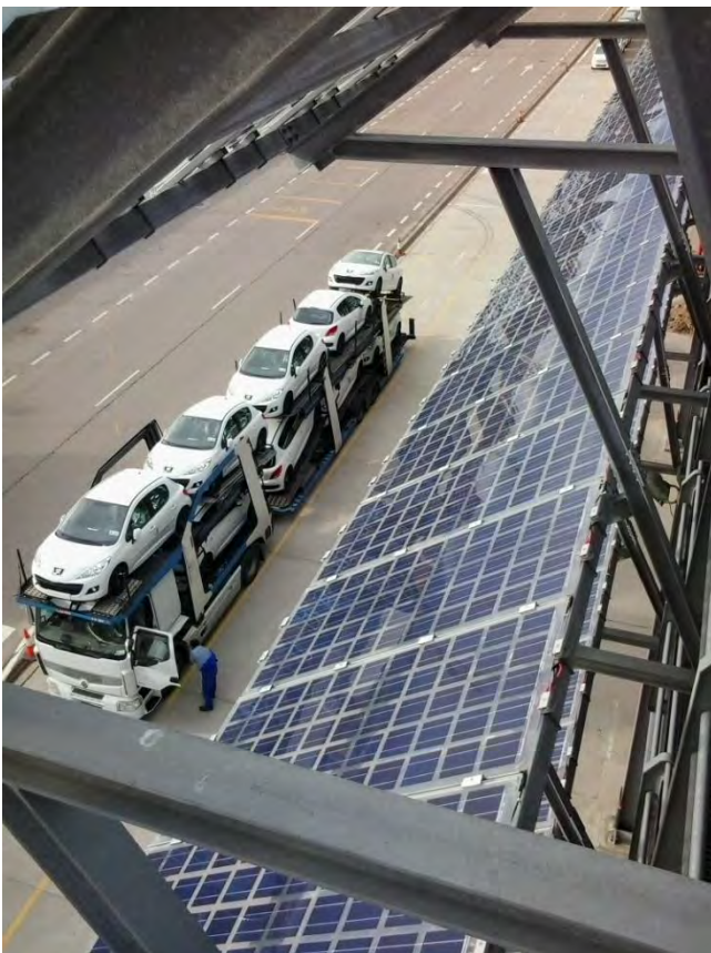
Figura 2.4.3 Instalación solar fotovoltaica en silo de automóviles de la AP de Vigo
