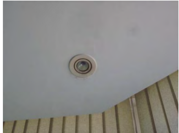
Figura 4.2.5 Lámpara halógena del edificio de Port Control
